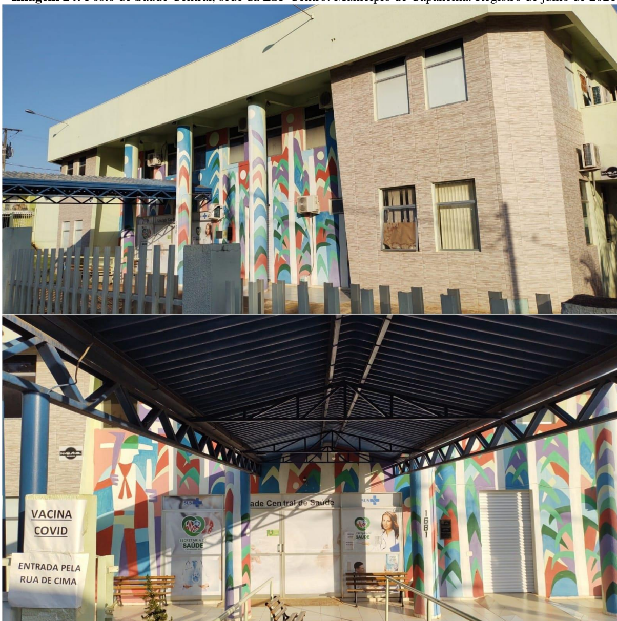
Imagem 24: Posto de Saúde Central, sede da ESF Centro. Município de Capanema. Registro de julho de 2021.
